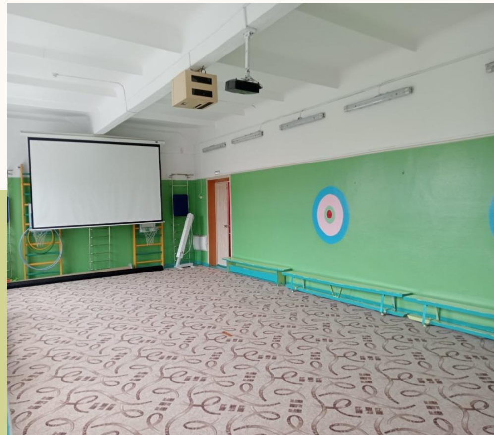
ПОСЛЕ РЕМОНТА (ПОБЕЛКА ПОТОЛКА И СТЕН)
