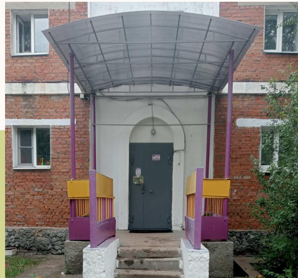
ПОСЛЕ РЕМОНТА (ЗАМЕНА ПОЛИКАРБОНАТА НАД КРЫЛЬЦОМ)
